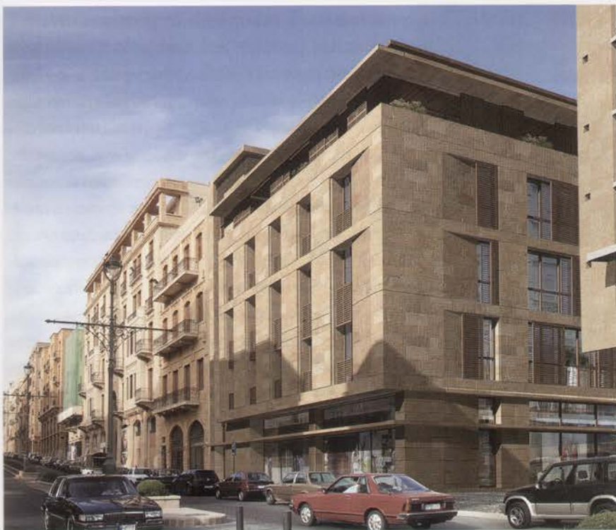
En haut : •Centre Starco rénové (ph. 2002) - Beyrouth - Addor & Julliard (1957) En bas : •Waqf - Foch Office Building - Centre-ville, Beyrouth - Nabil Gholam architecture and planning (2006) •Siège de la Banque Byblos - Achrafieh - Samir Khairallah (1996)
